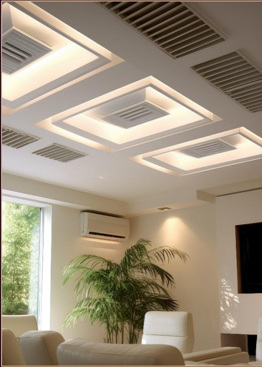
Climatisation centrale VRV dans tous les espaces
